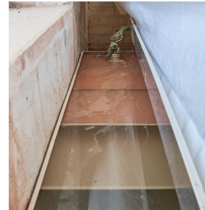
Oben: Integriertes Hydrosystem: Das Brauchwasser wird Absetzbecken gesammelt.
